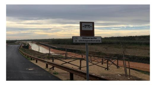
Sul lato Est del canale, lungo la S.P. 38, nonché sugli attraversamenti P.02 e P.05 realizzati è stata installata una barriera stradale al fine di tutelare e salvaguardare la sicurezza degli utenti fruitori della viabilità provinciale nei confronti della potenziale situazione di pericolo rappresentata dal canale.
