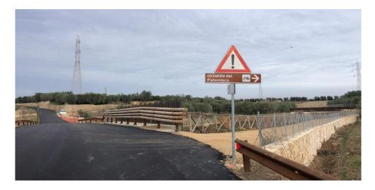
Inoltre a partire dall'innesto con la SP 38 è stato eseguito il rifacimento della pavimentazione stradale della viabilità esistente e idonea segnaletica stradale.
