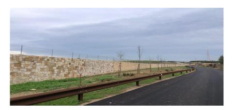
Nell'intersezione dell'impluvio 1 con la SP 38 è stato realizzato l'attraversamento P.02, lungo 9 m costituito da una campata unica. Il manufatto è stato rivestito con conci con pietra messi in opera a filari orizzontali con disposizione a correre, al fine di ridurre al massimo l'impatto ambientale ed estetico.
